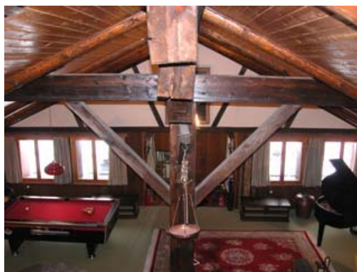
Vue partielle du séjour de l'étage
