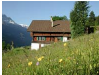
Vue sur la façade latérale du chalet l'Hermitage au printemps
